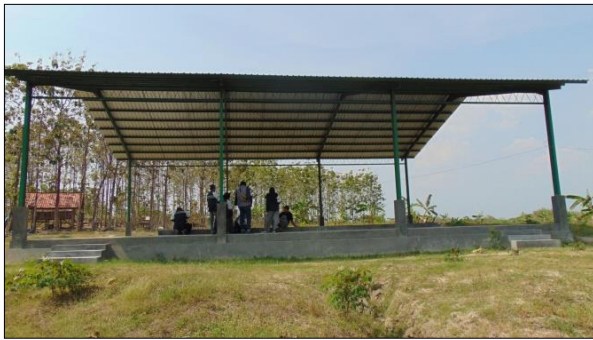
Gambar 1.1. Bangunan yang direncanakan untuk penempatan replika fosil
